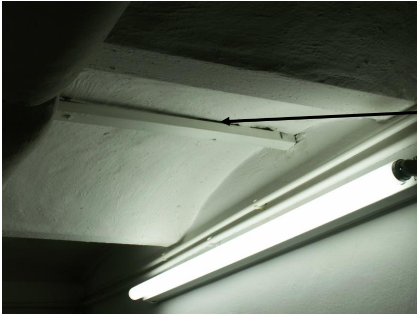
Strop piwnicy - ceramiczny, odcinkowy na belkach stalowych.
