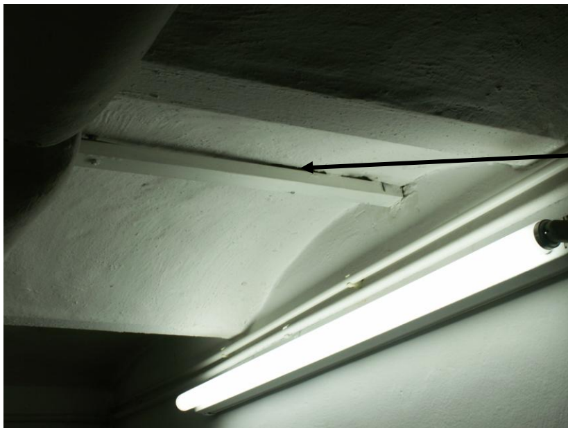
Strop piwnicy - ceramiczny, odcinkowy na belkach stalowych.
