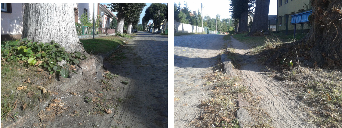
Fot. 2,3: Istniejący stan krawężników na ul. Szkolnej
