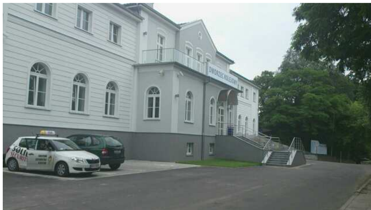
Zdjęcie 2. PKP Dworzec Kolejowy w Gryfinie
