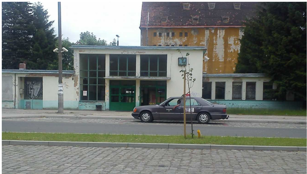
Zdjęcie 4. PKP Dworzec Kolejowy w Chojnie
