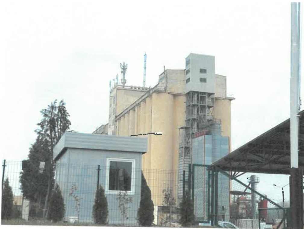
Zał. nr 1: Widok ogólny instalacji radiokomunikacyjnej.
