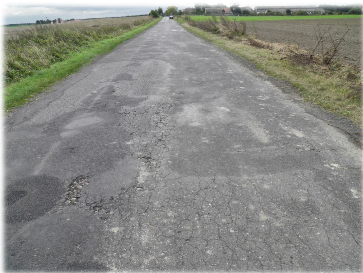
Fot.3. Spękania i ubytki w nawierzchni na całej szerokości.
