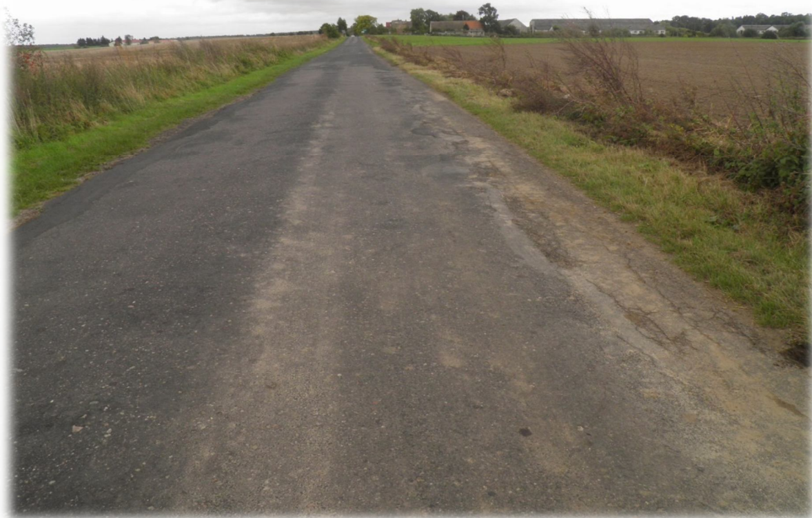
Fot. 3. Ułamane krawędzie jezdni.
