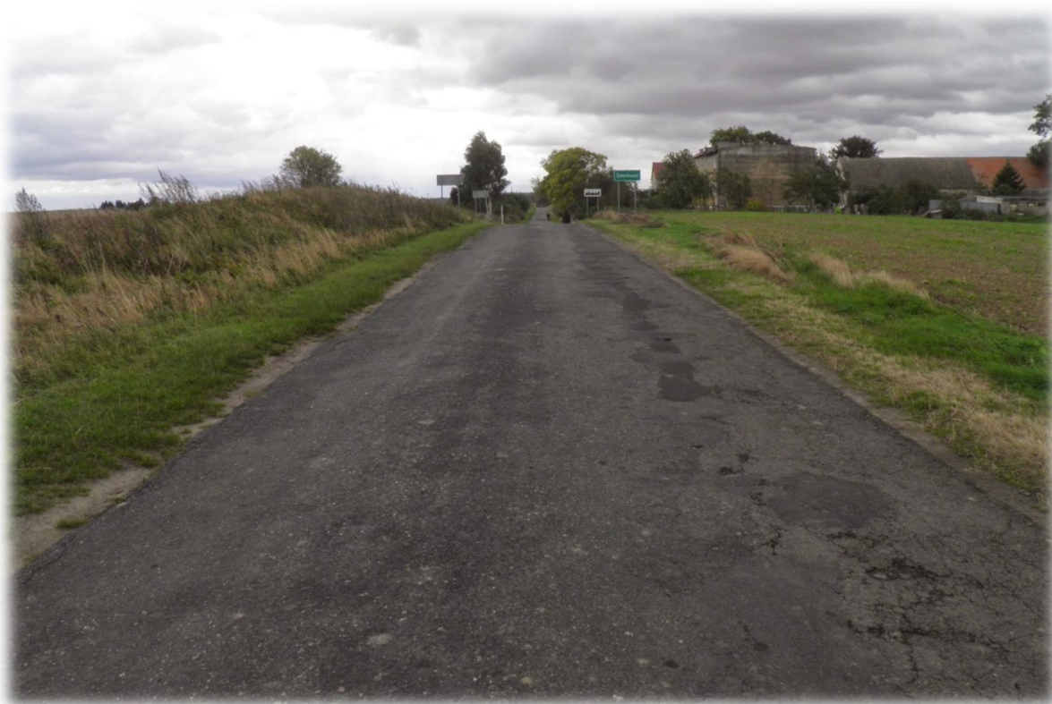
Fot. 1. Liczne łaty na prawym brzegu jezdni i zauważalne osiadanie tej strony jezdni.
