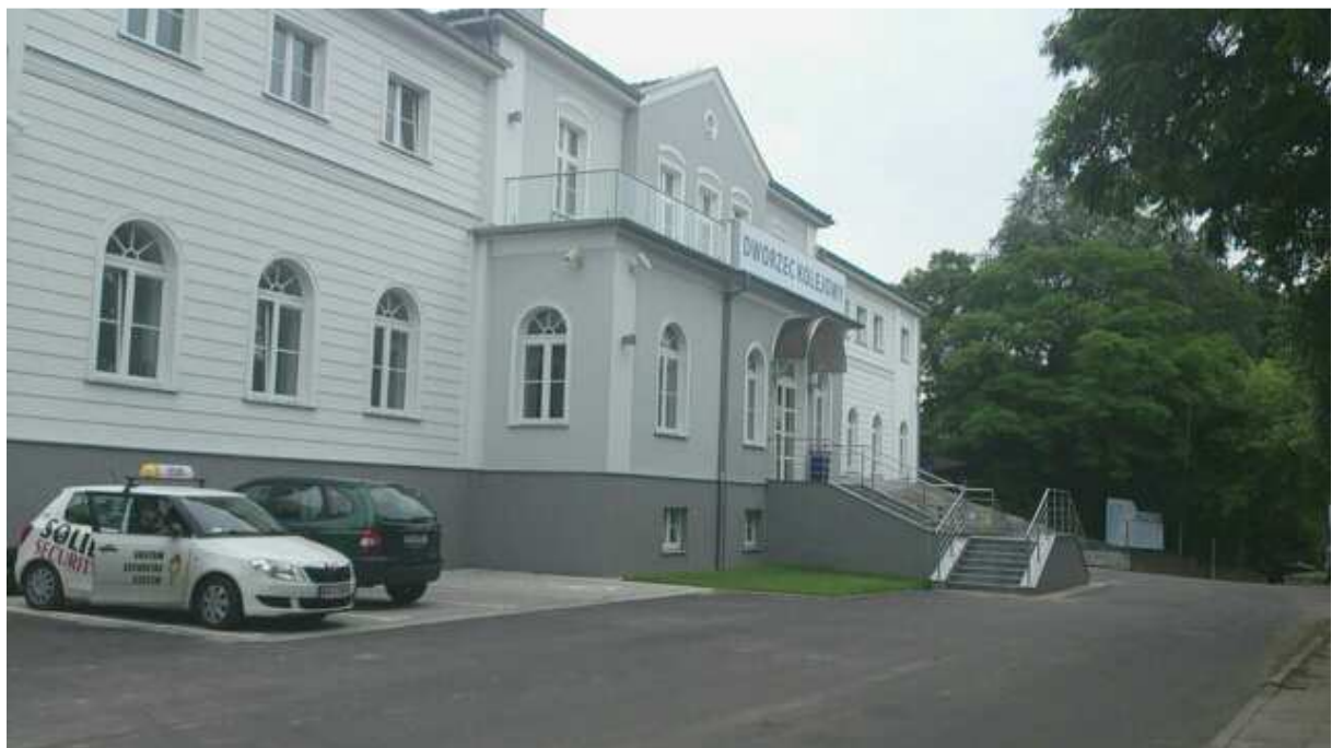
Zdjęcie 2. PKP Dworzec Kolejowy w Gryfinie
